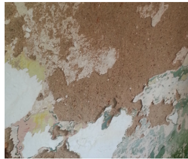
Figuur 2: Verzandingproces van de historische wand Foto: Coen van der Spek
